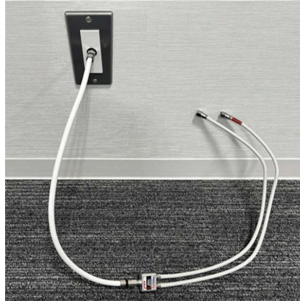
壁のテレビユニットに取り付けたケーブルに分波器を取り付けます。
